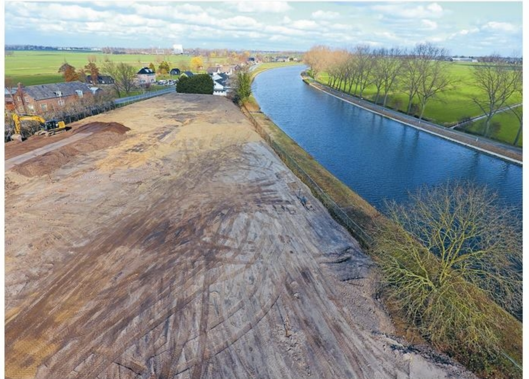
• Een overzichtsfoto van het noordelijk deel van het terrein van Betonson.
